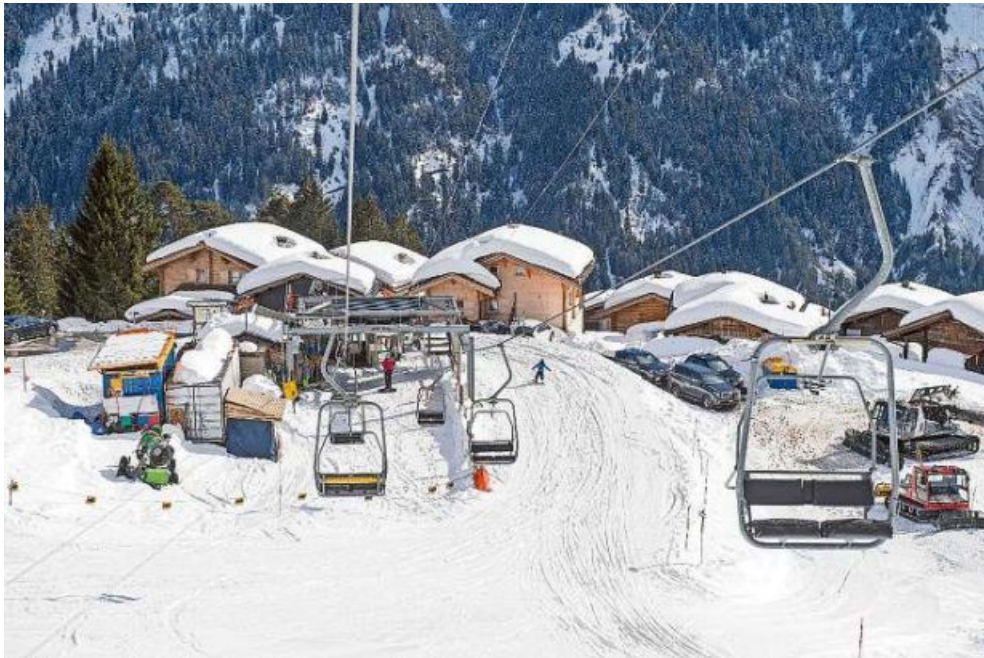
Die Sessel am Hochwang (hier Blick zur Talstation) werden im kommenden Winter leer bleiben.
